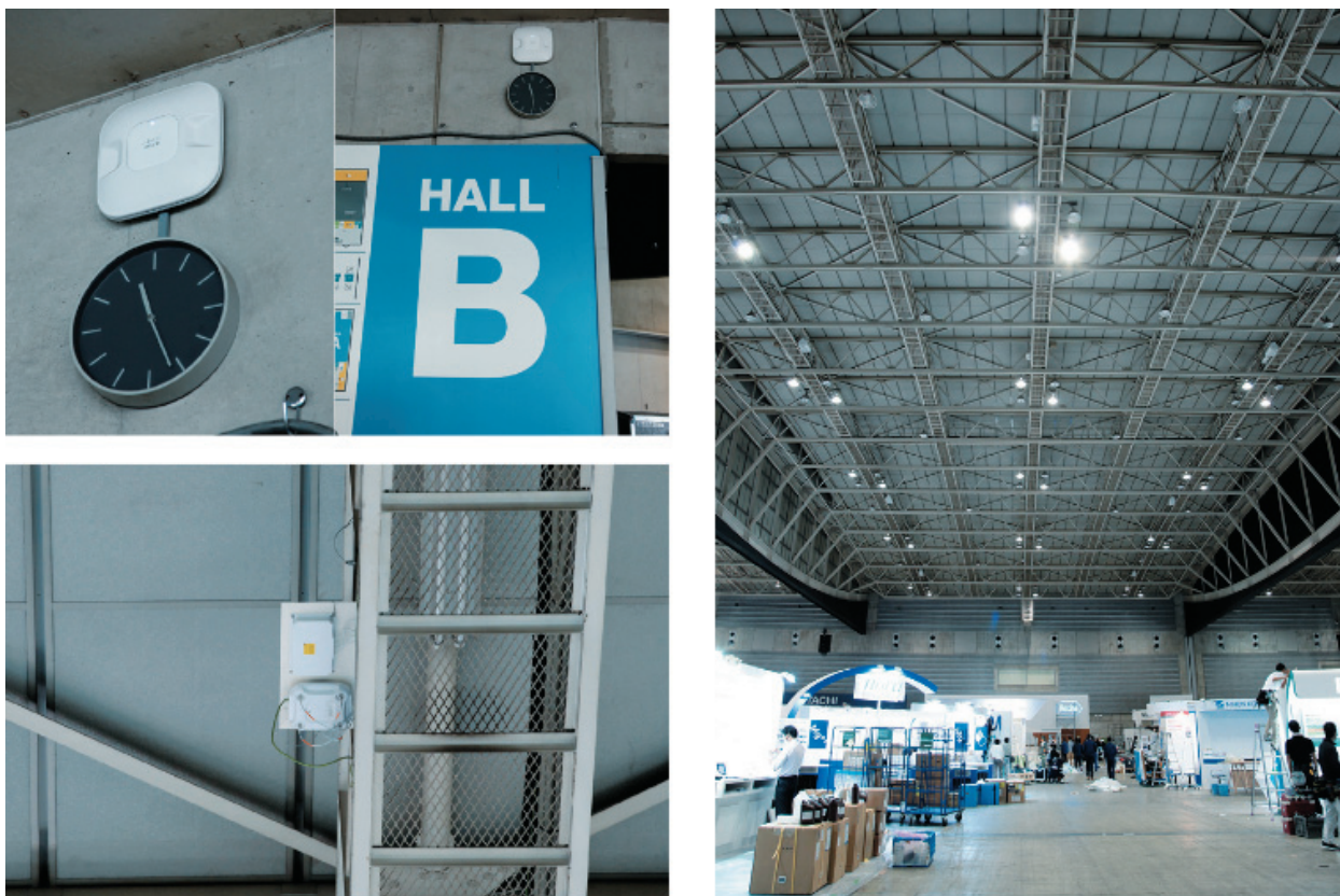
(左上)ホール入口のアクセスポイント。(左下)ホール天井・キャットウォークのアクセスポイント。(右)ホール入口から見たキャットウォーク。100Vの電源ラインが不要なため、このような場所への設置にも適しています。
