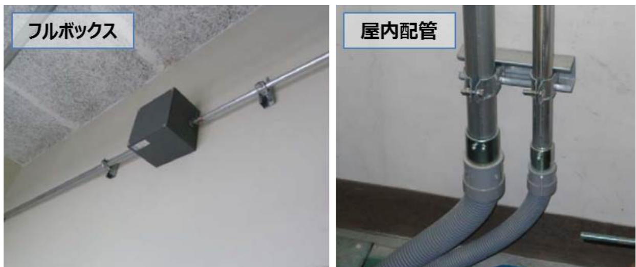
図 4-1 配管工事イメージ
