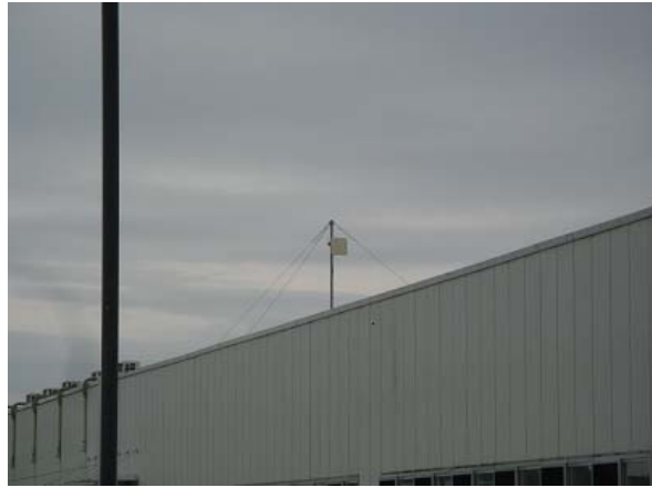
無線(FWA)アンテナ(気仙沼魚市場屋上)
