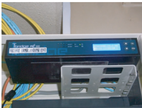
写真右 教室内に設置された屋内用AP 写真下 職員室に設置されたネットワークコントローラ
