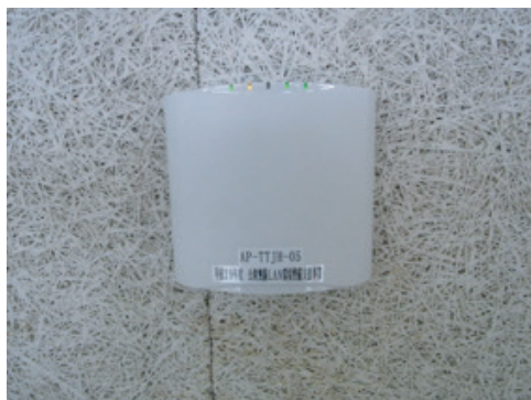
写真左 体育館内に設置された屋内用AP 写真下 体育館内に設置されたAP拡大
