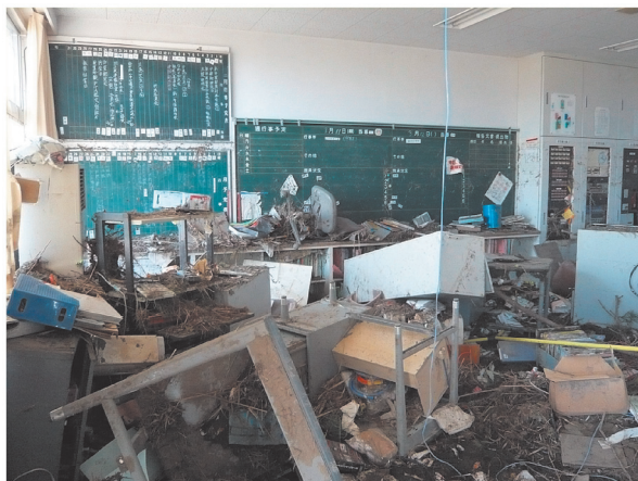
写真3-2 津波で書類やPCを流された職員室
